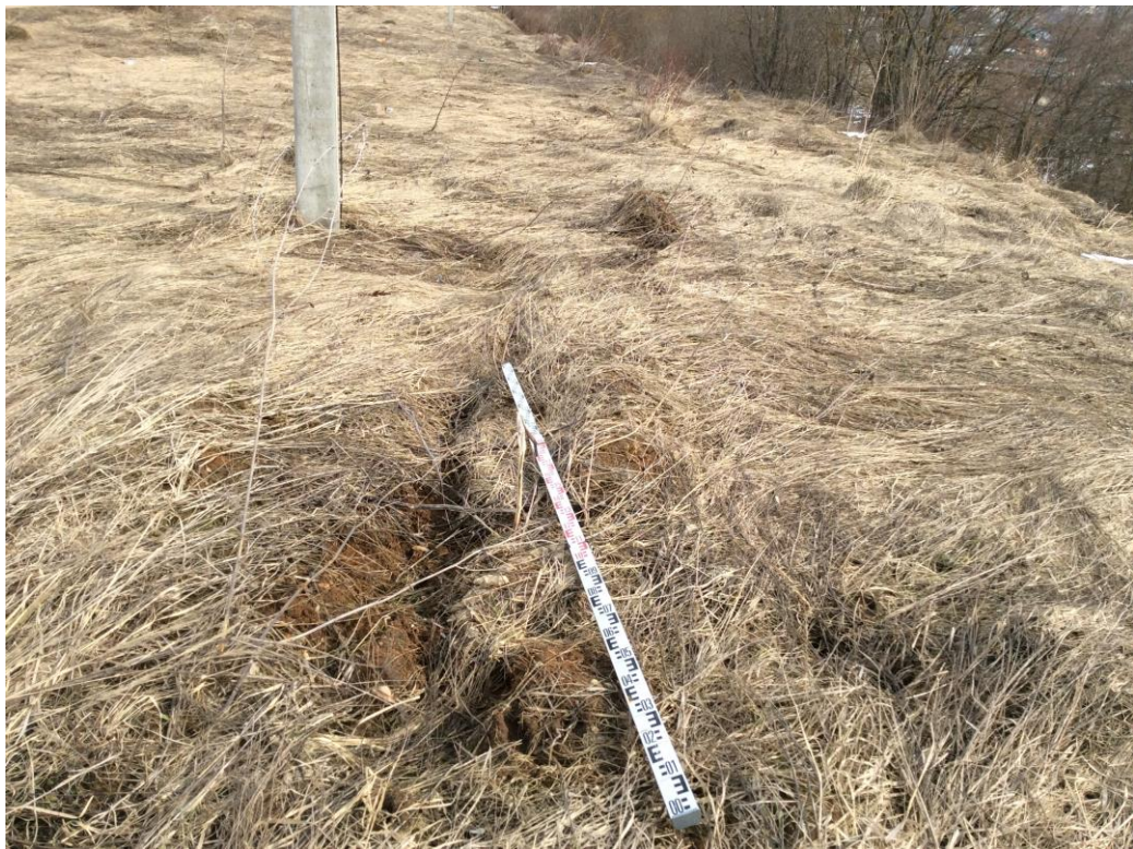
Рис. 12. Земельный участок под «Реконструкцию самотечного коллектора КТЗ, район ул. Турбостроителей – ул. Родниковая в г. Калуга». Видовая точка 3. Вид с юго-запада.
